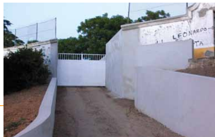
Rampa construída pelo Município permite melhores acesso
